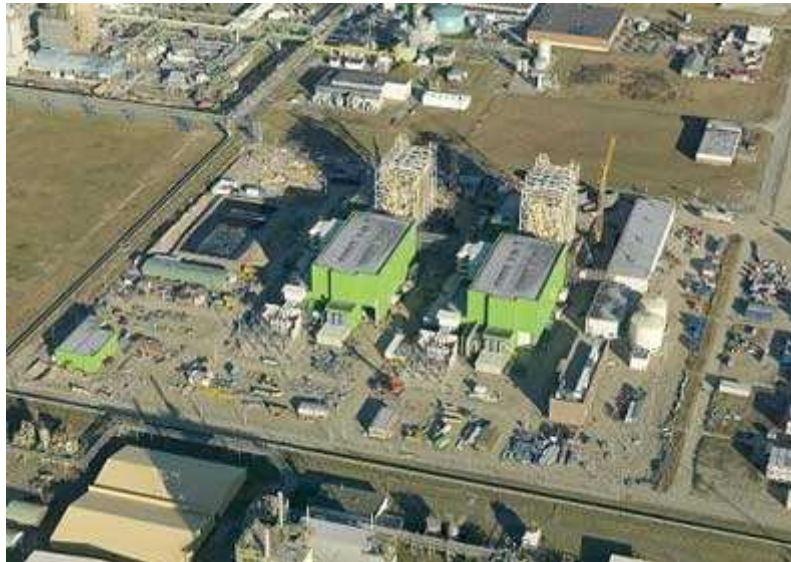
[ Vue aérienne de la centrale en septembre 2009 ]
